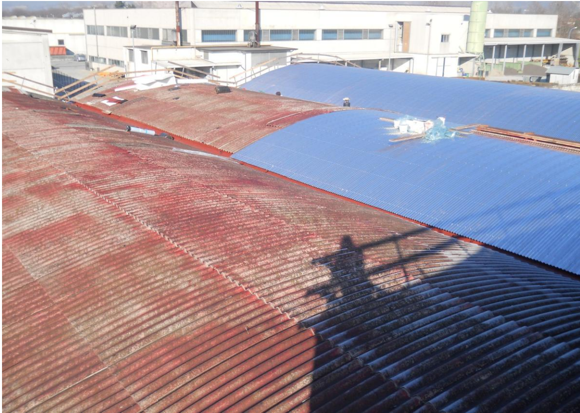
SMALTIMENTO AMIANTO E RIFACIMENTO COPERTURE
