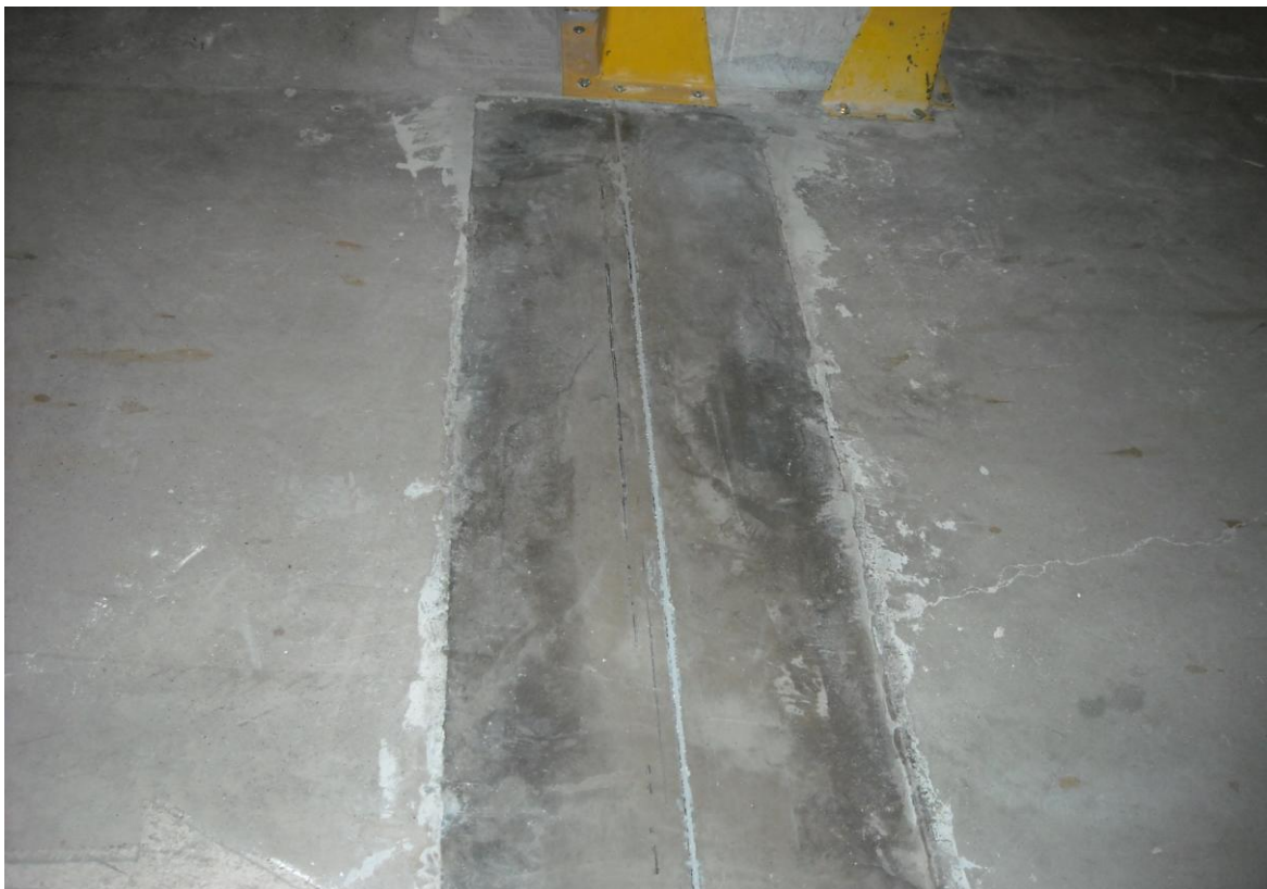
RIFACIMENTO DI GIUNTI STRUTTURALI
