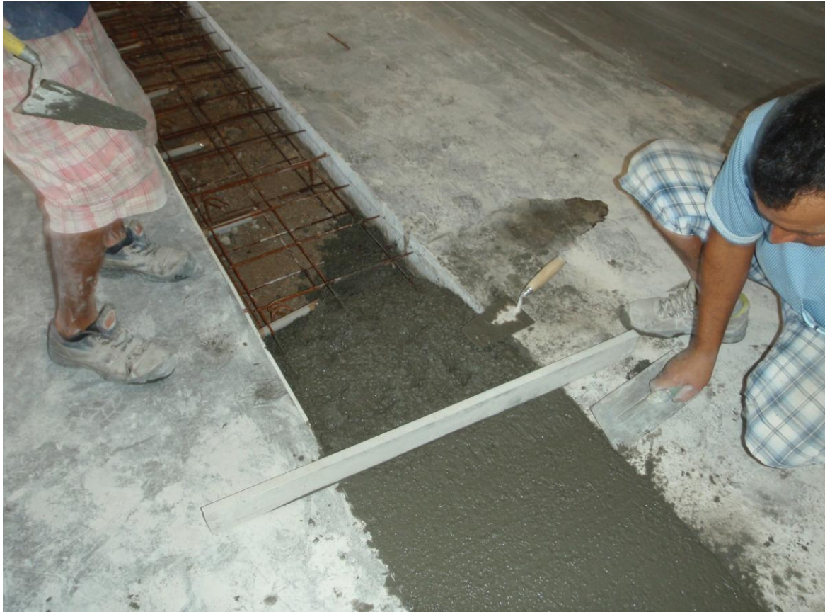
RIFACIMENTO DI GIUNTI STRUTTURALI
